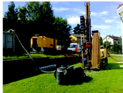
Figur 3.3 Trykkluftdrevet boreutrustning for grunne geotermiske systemer ned til ca 250 meter. (Kilde: ABK Norge)
