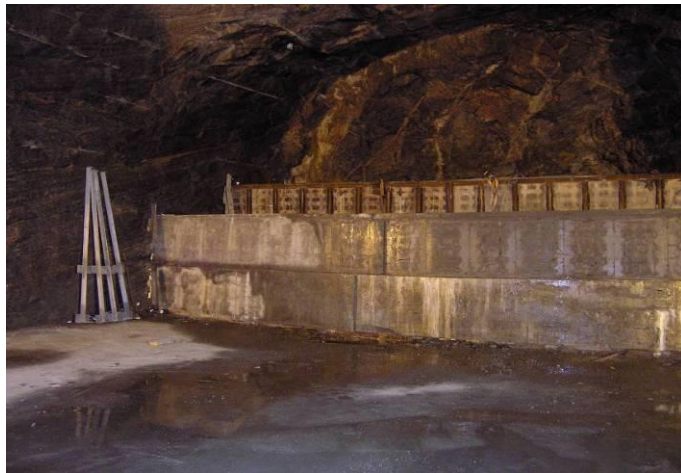
Figur 11: Øverst: Lagringstunnel ved Wergeland-Halsviks deponi i Gulen kommune. Nederst: Deponiområde for disponering av radioaktivt avfall med naturlig forekommende radioaktive stoffer fra petroleumsindustrien ved Wergeland-Halsvik. Foto: Statens strålevern.
