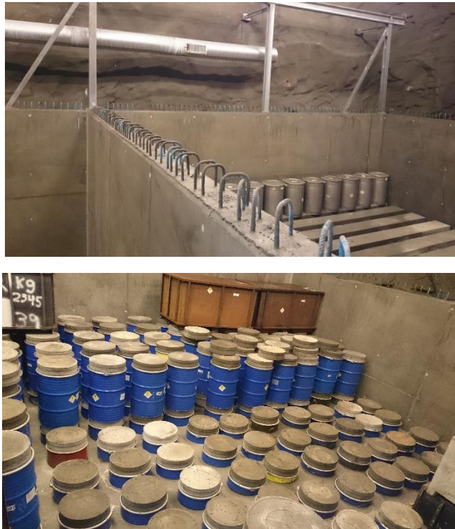
Figur 13: Deponert radioaktivt avfall i KLDRA-Himdalen. Foto: Statens strålevern.
