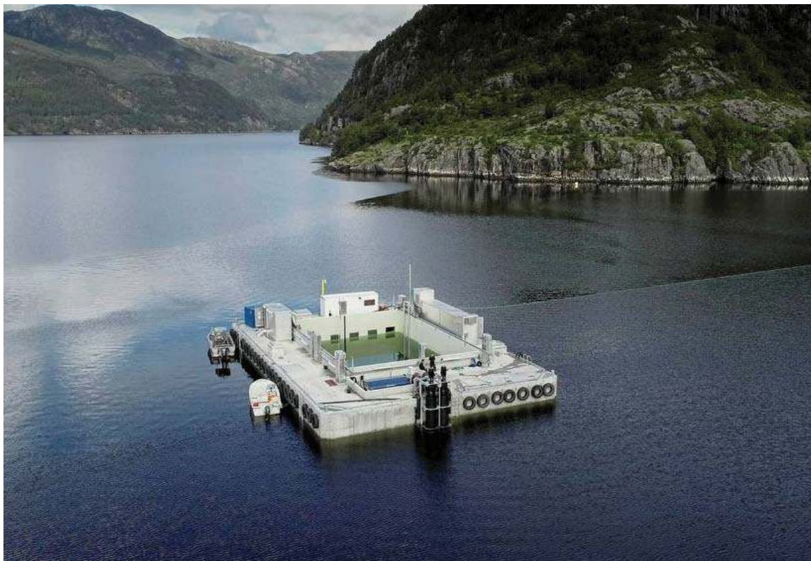
Betongmerden til Engesund Fiskeoppdrett.
